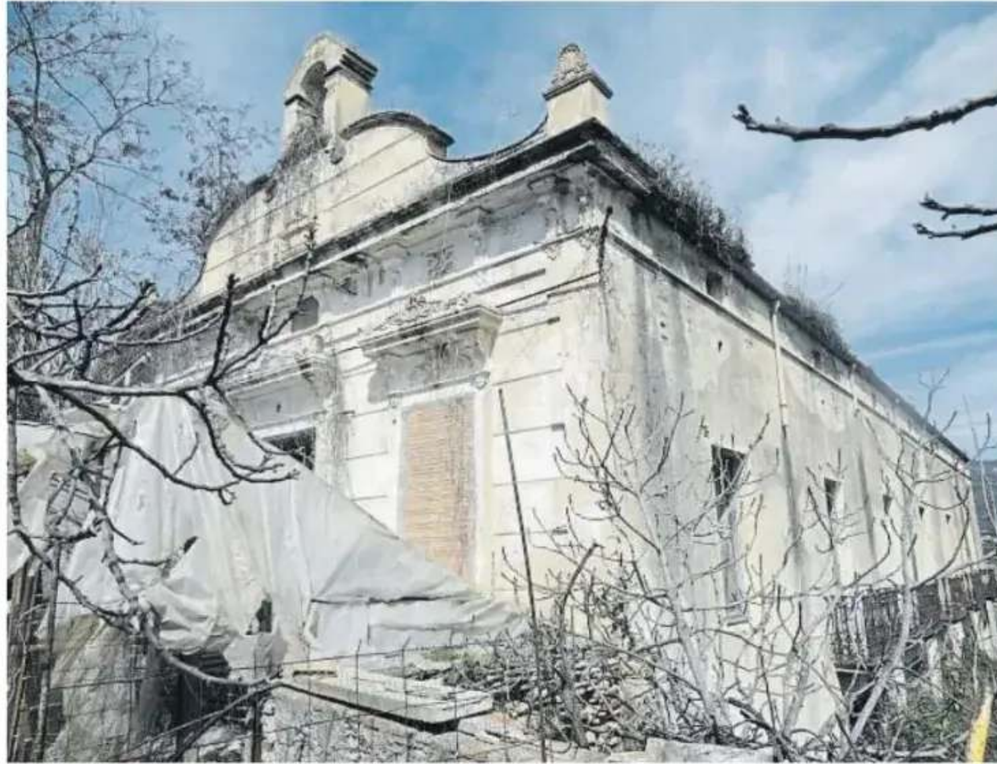
El antiguo hospital de Esparreguera ya presentaba este aspecto abandonado en 2019
